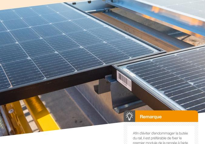
Pose du **premier** module d'une rangée premier module de la rangée à l'aide de Soprasolar® Clips avant de mettre en place les suivants.
